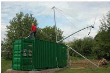
Aufrichten des Mastes mit einer Seilwinde auf dem Container
