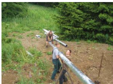
Montage des Mastes
